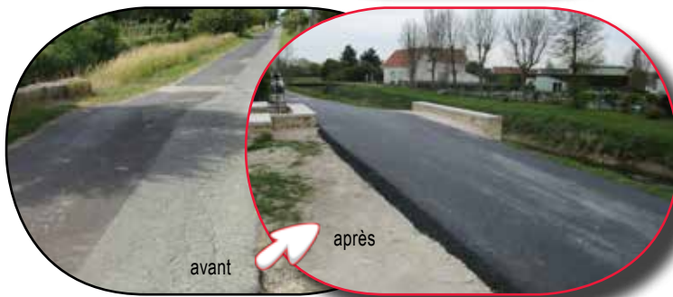
PONT RUE DU CANAL
