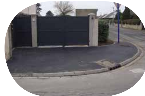
Rue Robelin Réfection de 15 m 2 de trottoirs.
