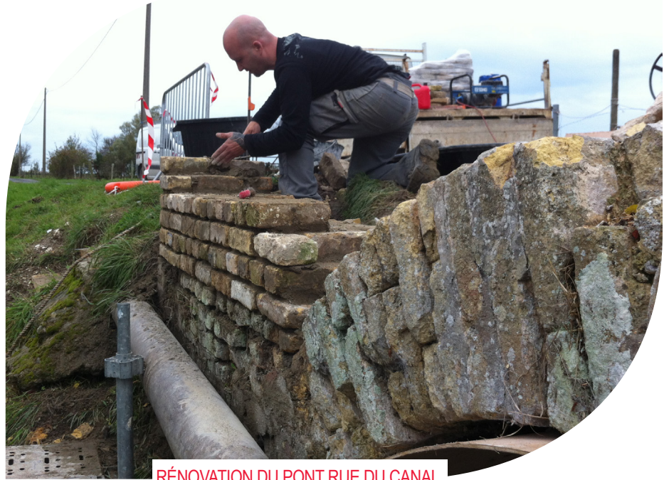
RÉNOVATION DU PONT RUE DU CANAL
