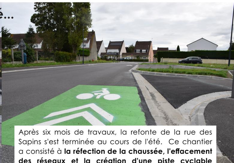
Après six mois de travaux, la refonte de la rue des Sapins s'est terminée au cours de l'été. Ce chantier a consisté à **la réfection de la chaussée, l'effacement des réseaux et la création d'une piste cyclable** facilitant l'accès au collège Boris Vian en deux-roues. Un boulo-drome va être prochainement réalisé.
