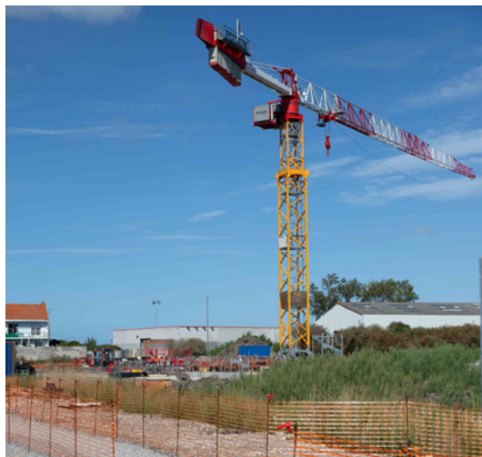
LES TRAVAUX ONT DÉBUTÉ. OUVERTURE EN 2026
